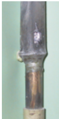
Links: So erkennen Sie eine Bleileitung: Blei ist weich, lässt sich leicht biegen und schon mit einer Münze anritzen. Rechts: Blei trifft Kupfer - in diesem Haus wurde nur teilsaniert. Bilder mit freundlicher Genehmigung von www.nlga.niedersachsen.de .
